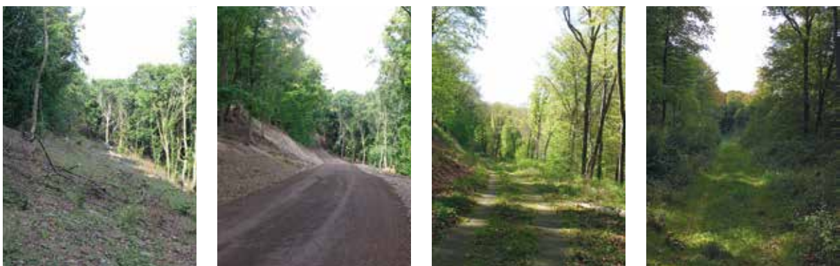
Abb. 4: Waldwegbau (v.l.n.r): Trassenaufrieb, Wegebau mit LKW-befahrbarer wassergebundener Decke (Zustand 2013), durch natürliche Sukzession begrünter und schließlich vollständig eingewachsener Waldweg im Jahr 2018 (Fotos: Sebastian Turck, Dienstleistungszentrum Ländlicher Raum (DLR) Westerwald-Ostefel)
