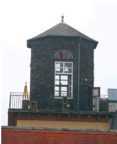
Abb. 15: Sternwarte 2020 mit Knopf; links vorn die Westsäule mit aufgebautem Stativ
