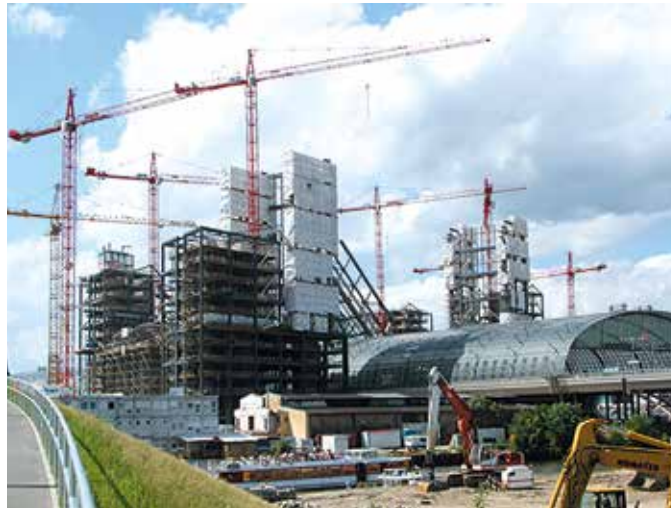
Abb. 1: Großbaustelle mit zahlreichen ingenieurgeodätischen Herausforderungen
