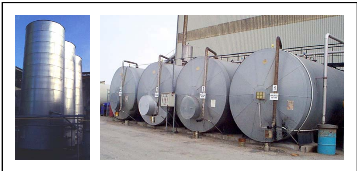
Bild 4-8: Lagerung von Bitumen in stehenden und liegenden Zylindertanks
