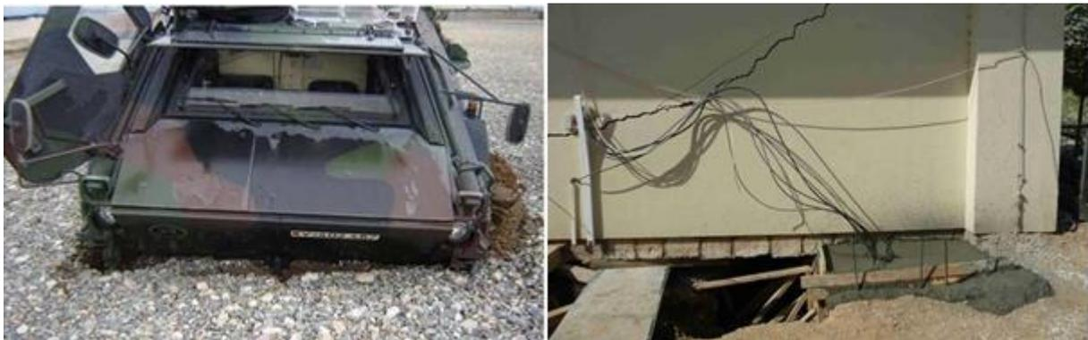
Abbildung 1.1 Dolinenartige Sackung unterhalb eines Einsatzfahrzeugs (links), Hohlraumbildung unterhalb eines Gebäudes und Abriss der gesamten Gebäudeecke (rechts)
