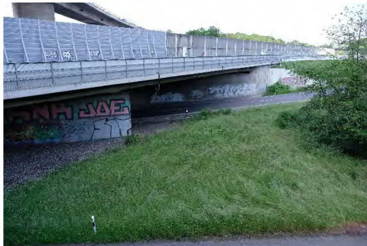
Abbildung 2: Ansicht des Versuchsbauwerks aus [5]
