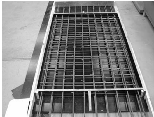
Bild 4.2: Schalung und Bewehrung der Versuchskörper (ESS) vor dem Betonieren
