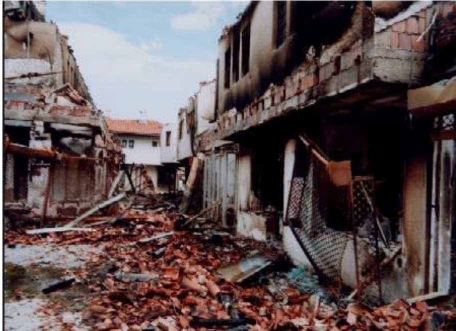
Abb. 18: Beispiel für die Beeinträchtigung der künstlich geschaffenen Umwelt (hier: zerstörte Infrastruktur) 134
