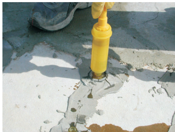
Abbildung 7.24: Anwendung der EP-Injektion mittels Selbstinjektor bei angesprengten Platten
