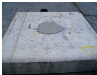
Abbildung 8.5: Eingebachter Betonersatz
