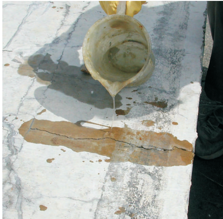
Abbildung 6.10: Instandsetzung mittels Tränkung
