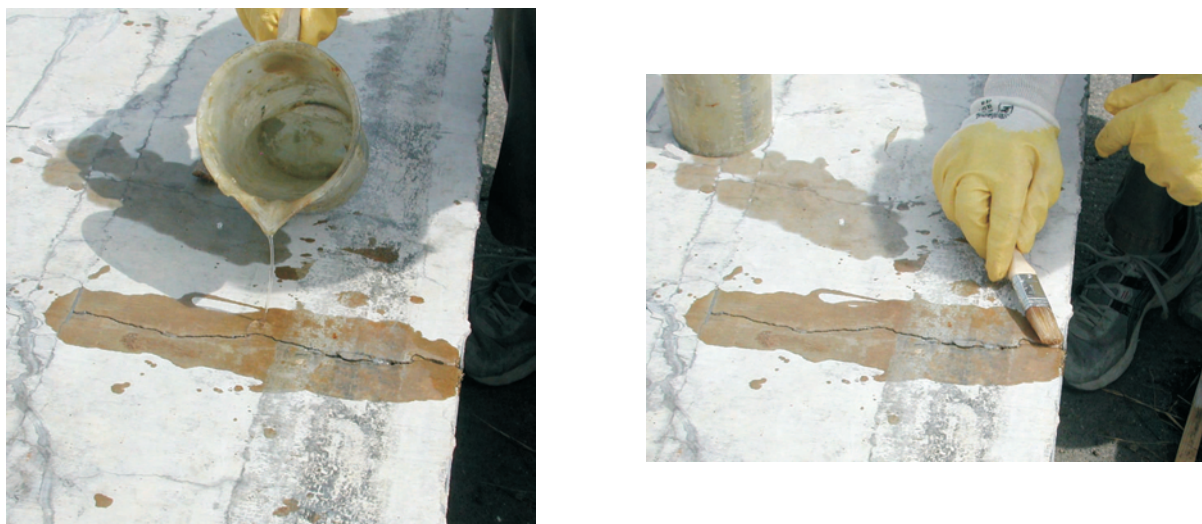
Abbildung 7.25: Anwendung der EP-Tränkung bei Trennrissen in angesprengten Platten
