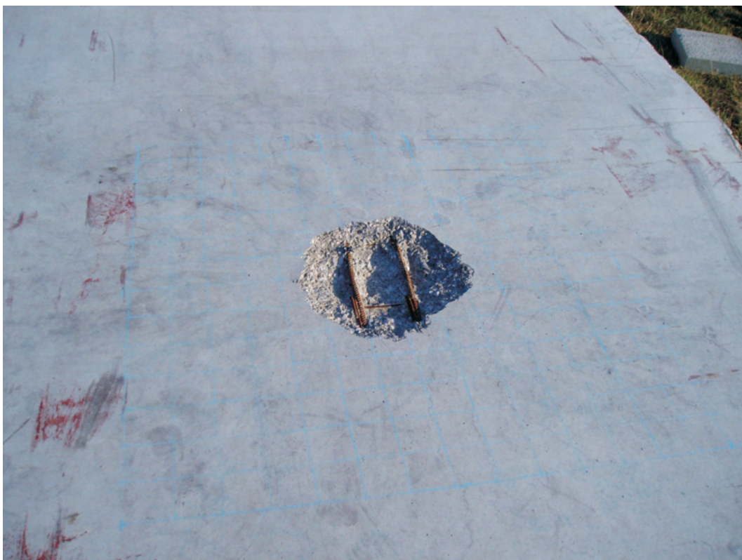
Abbildung 4.2: mit Kreide aufgebrachtes Messraster (hellblau)
