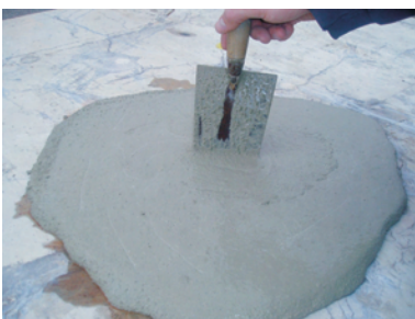
Abbildung 8.4: Einbau des Betonersatzes
