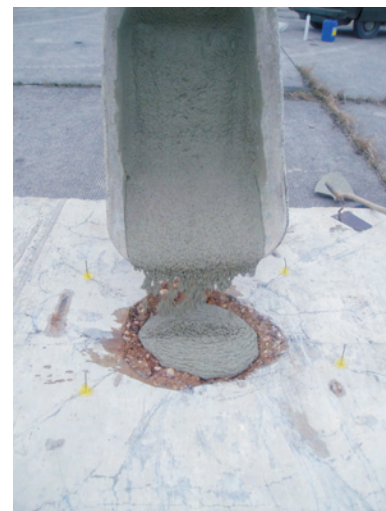
Abbildung 8.3: Aufbringen des Betonersatzes
