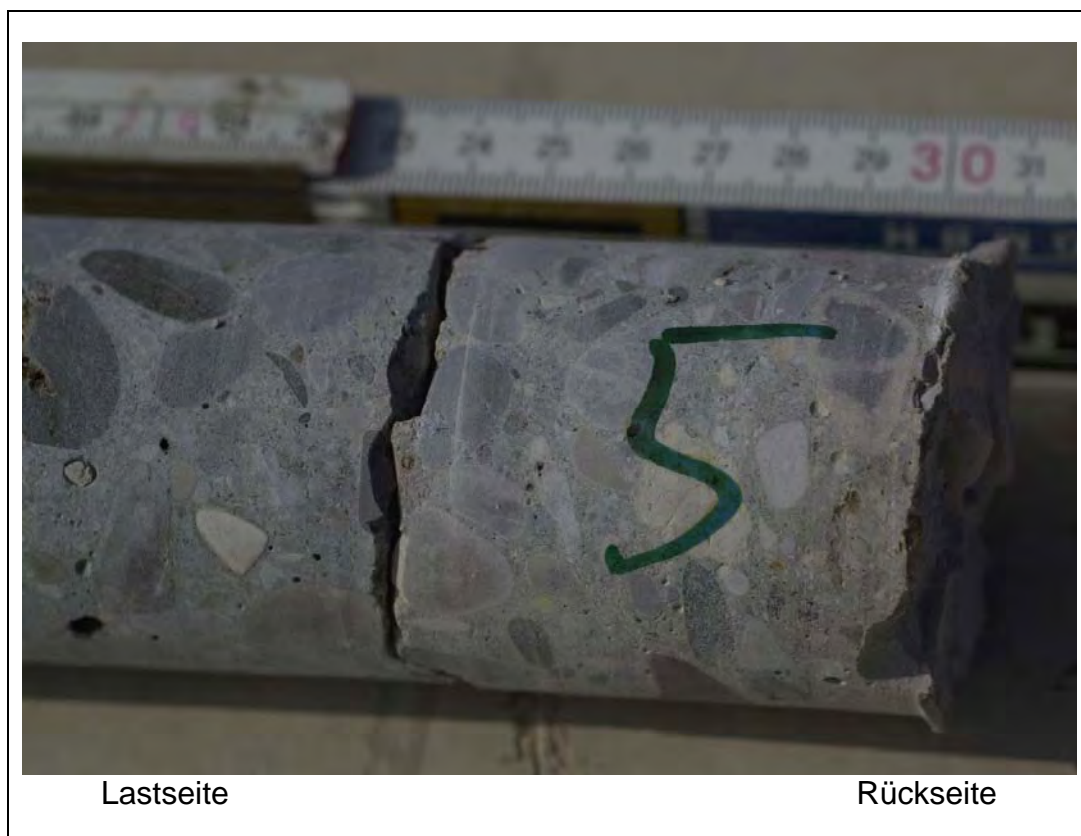
Abb. B.2.5: Detailansicht Bohrkern Nr. 5 Platte WTD 8
