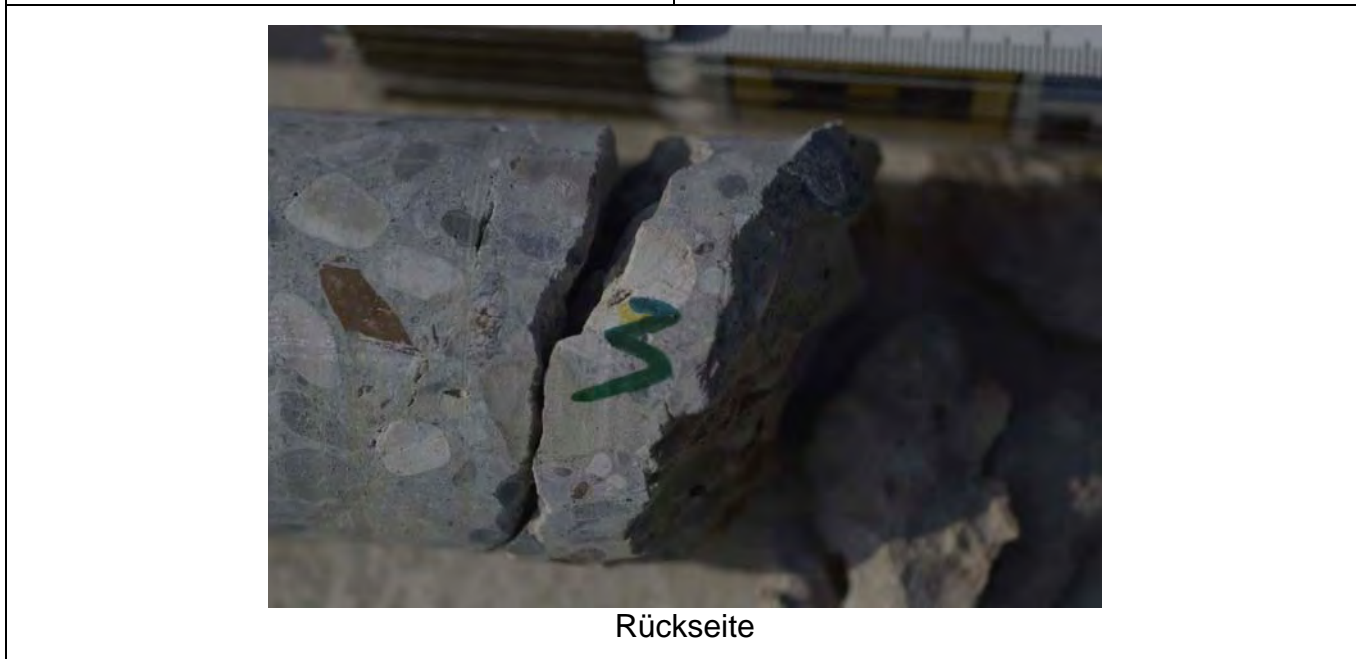
Abb. B.2.7: Detailansichten Bohrkern Nr. 3 Platte WTD 8
