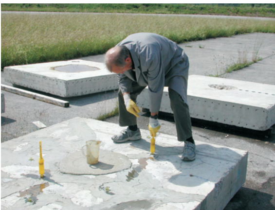
Abbildung 7.24: Anwendung der EP-Injektion mittels Selbstinjektor bei angesprengten Platten
