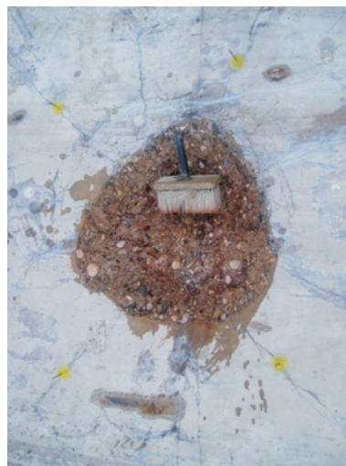
Abbildung 8.2: Vornässen des Kraterbereichs
