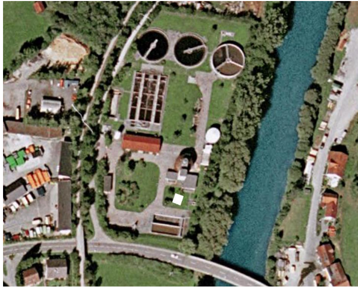
Abbildung 4.1: Luftbild der städtischen Kläranlage Viechtach mit Versuchsanlage [www.earth.google.de]
