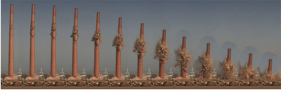
Abbildung 4.2: Zeitreihe einer Gebäudesprengung (Fotomontage der originalen Abbildung aus [95]).
