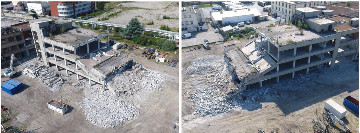
**Abbildung 4.1:** Drohnenaufnahmen eines teilweise eingestürzten Stahlbetongebäudes in Lyon, Frankreich [97, 124].
