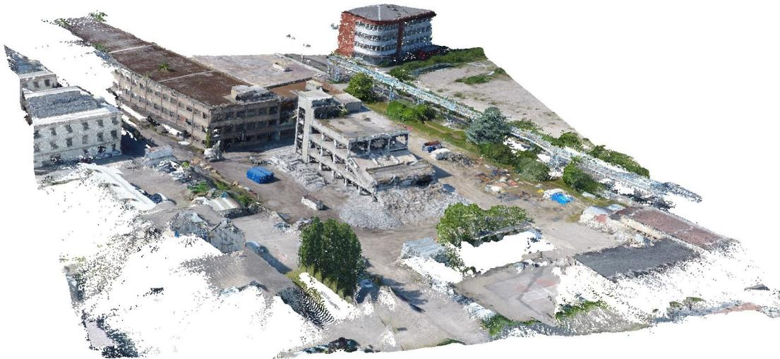
**Abbildung 4.8:** Photogrammetrisch erzeugte 3D-Punktwolke des teilweise eingestürzten Stahlbetongebäudes in Lyon aus dem Datensatz #2.
