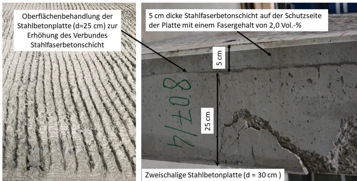
Abbildung 4-4: Verstärkung der Stahlbetonplatte mit Stahlfaserbeton mit einem Fasergehalt von 2,0 Vol.-%.
