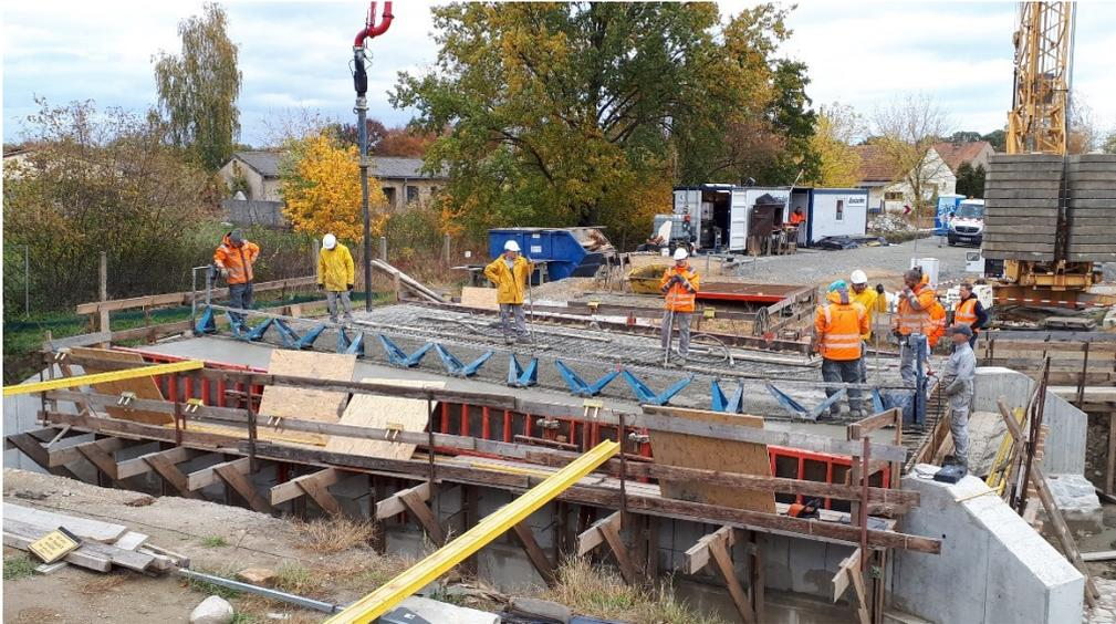
Abb. 4: Brückenbaustelle – Carbonbeton als Ortbeton
