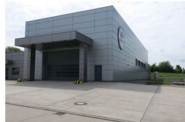
Halle Multiaxialer Prüfstand (HMP) (Quelle WTD41)
