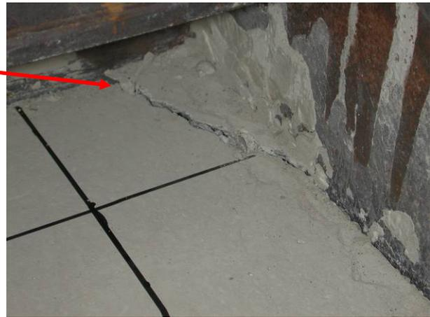
Bild 5.64: Betonabplatzung des Trägers ET4.
