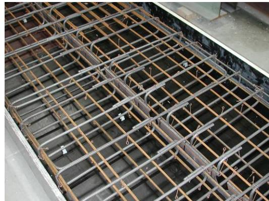
Bild 5.9: Ausschnitt des Trägers vor dem Betonieren.
