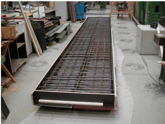
Bild 5.8: Gesamtansicht des Trägers vor dem Betonieren.
