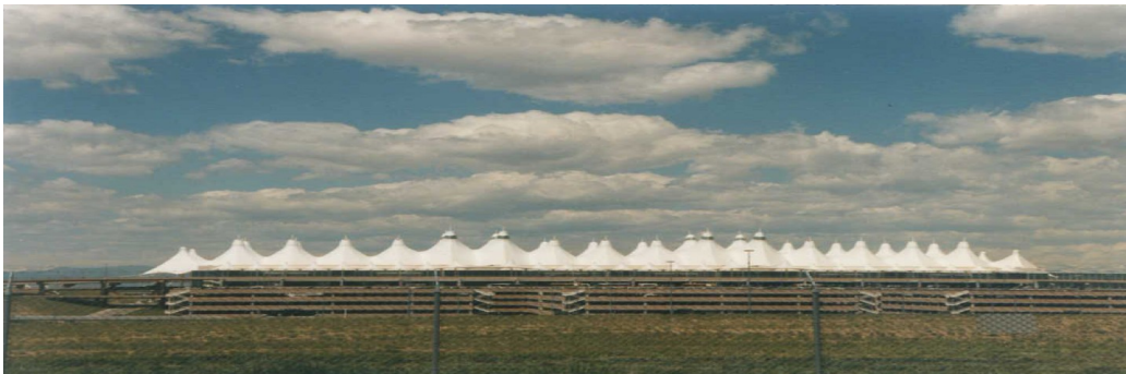
Terminal des „Denver International Airport“ mit vorgelagerten Parkdecks (5-Ab-16-2)
