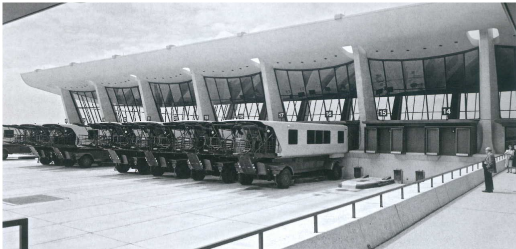
Washington Dulles „Plane-Mates“ (Mobile Lounges) an der Terminal-Luftseite (5-Ab-5-3)
