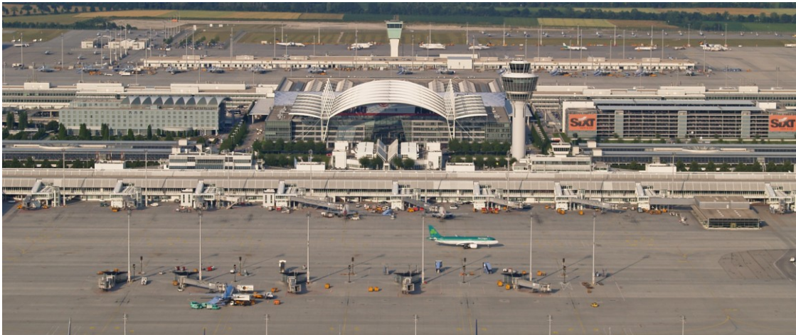
Terminal 1 mit Einsteigestationen (vorne im Bild) (8-Ab-7)
