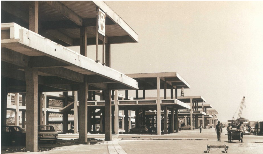
Rohbau der sechs neuen Warteräume auf dem Vorfeld (6-Ab-5)
