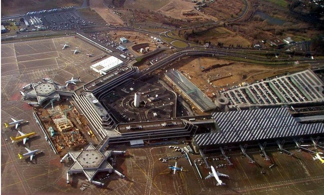
Flughafen Köln/Bonn - Luftbild 2000 mit Terminal 1 (links) und Terminal 2 (rechts) (5-Ab-8-2)
