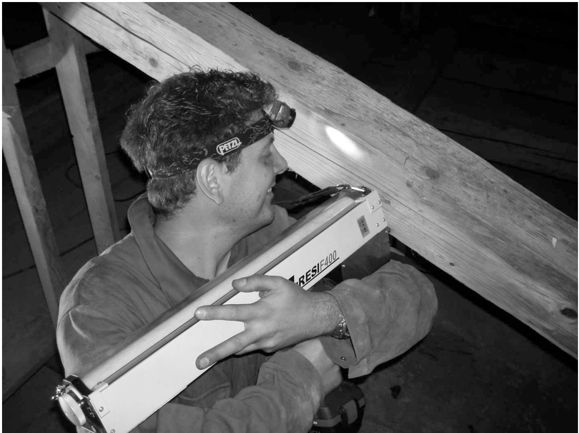
Abb. 3.7: Durchführung einer Bohrwiderstandsmessung durch den Autor im Dachwerk der Pfarrkirche Weyarn
