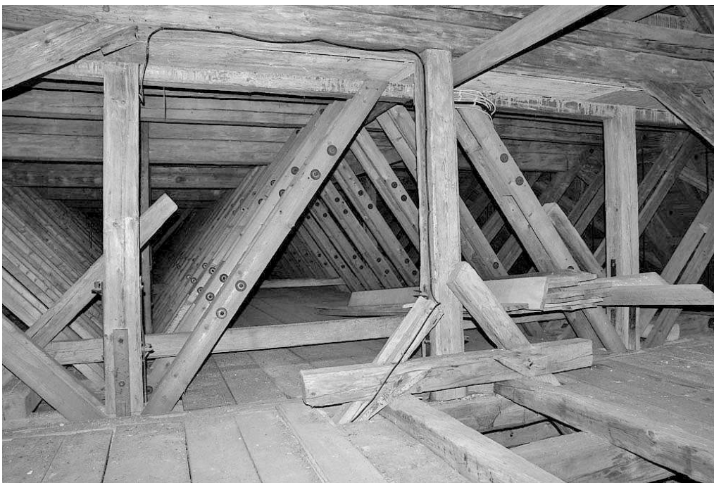
Abb. 2.48: Ertüchtigung des Altenerdinger Dachwerks (Fachwerkstruktur)
