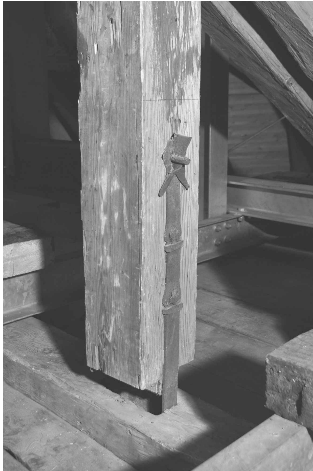
Abb. 2.25: Pfarrkirche Lenggries. Hängeeisen mit Eisenbolzen, Beilagscheibe und Splint
