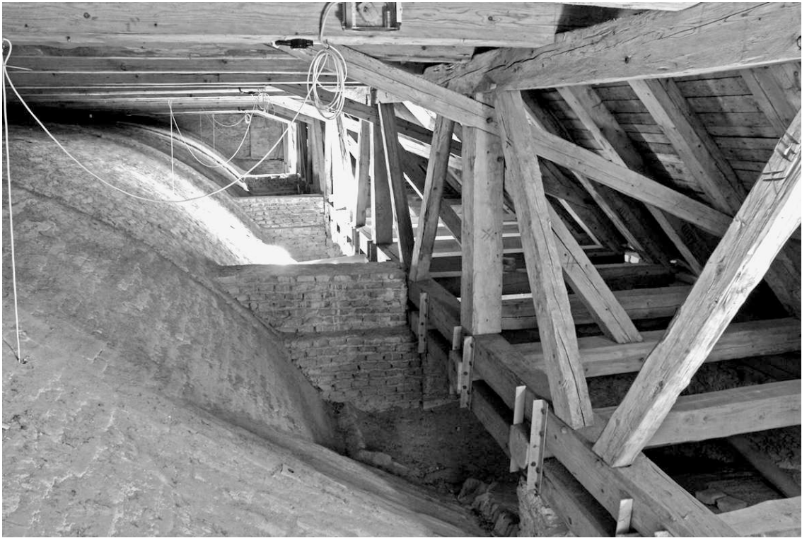
Abb. 2.52: Vertikal nachgiebige Stuhlwände im Dachwerk der Pfarrkirche Weyarn
