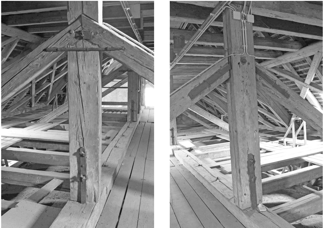
Abb. 2.28: Vorder- und Rückseite der Hängesäule im Dachwerk von St. Michael in München-Perlach
