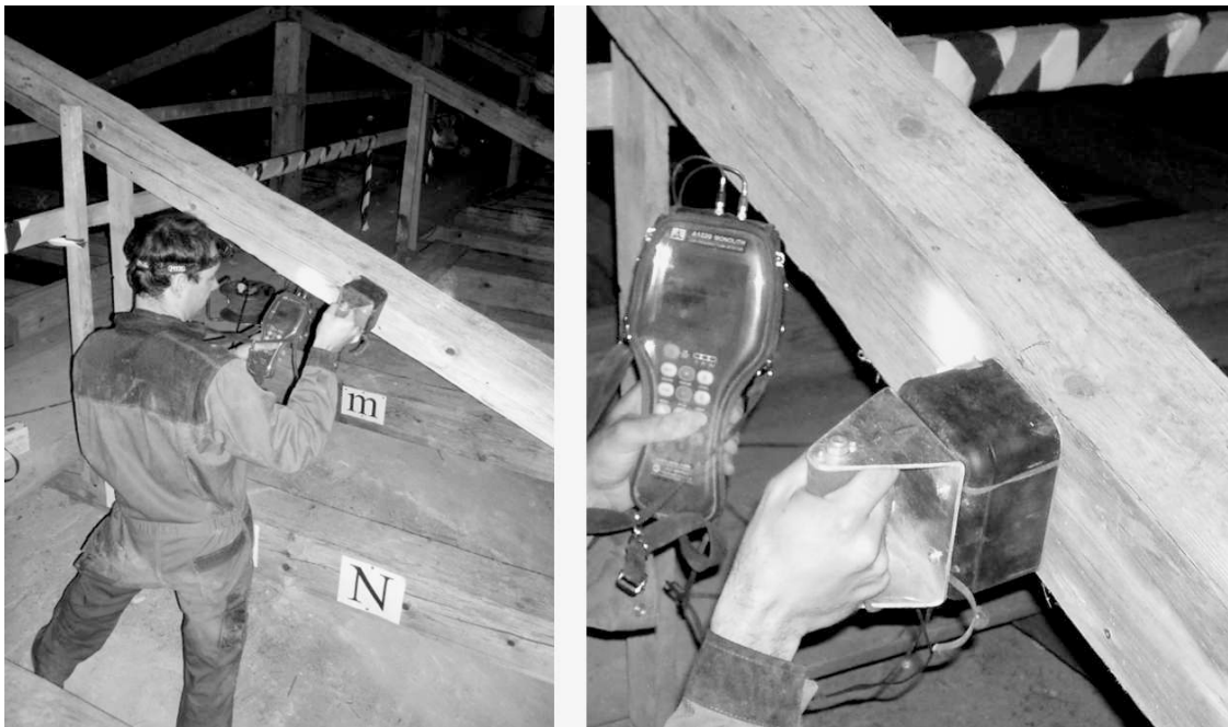
Abb. 3.10: links: Ultraschallechomessung des Autors in Zusammenarbeit mit A. Hasenstab, durchgeführt im Dachwerk der Pfarrkirche Weyarn; rechts: Prüfkopf und mobiler Messrechner der Firma ACSYS
