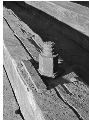
Abb. 2.30: Ev. Hl. Kreuz, Augsburg. links: Handgeschmiedete Eisenstangen, eingesetzt als Hängesäulen. rechts: Sechseckige Mutter am oberen Ende der handgeschmiedeten Eisenstangen
