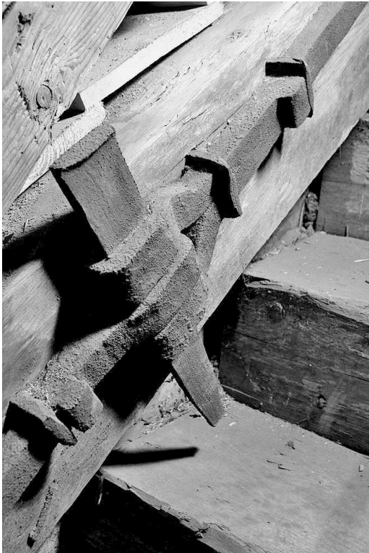
Abb. 2.37: Augsburg, ev. St. Ulrich. Eisenband mit Keil zur Unterstützung der Kreuzstreben
