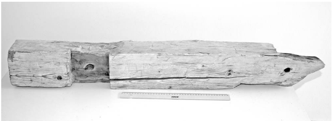
Abb. 3.13: Holzprobe aus dem Dachwerk der Pfarrkirche Baumburg zur Bestimmung der Festigkeits- und Steifigkeitswerte
