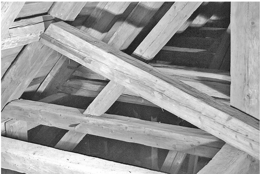
Abb. 2.33: Anschluss der Kreuzstreben zur Gewölbesicherung im Dachwerk der Pfarrkirche Tunttenhamen
