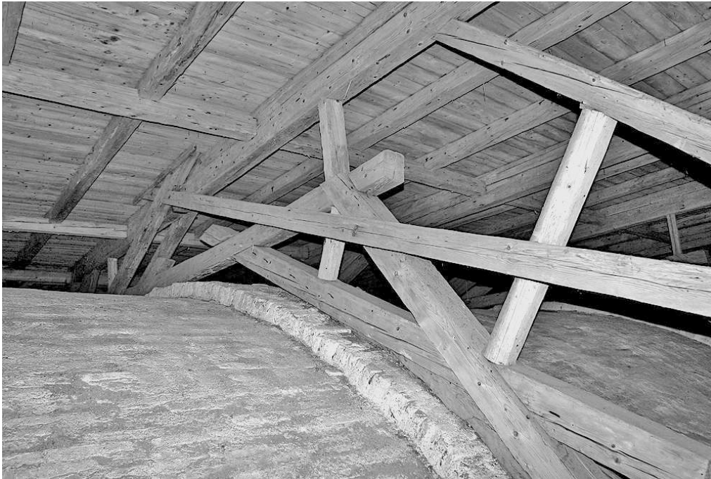
Abb. 2.57: Sprengwerk im Dachwerk der Baumburger Kirche
