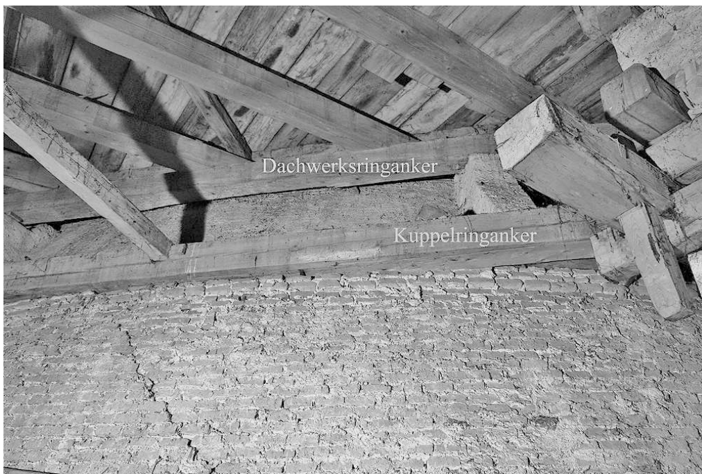
Abb. 2.43: Kuppel- und Dachwerksringanker im Dachwerk der Murnauer Pfarrkirche
