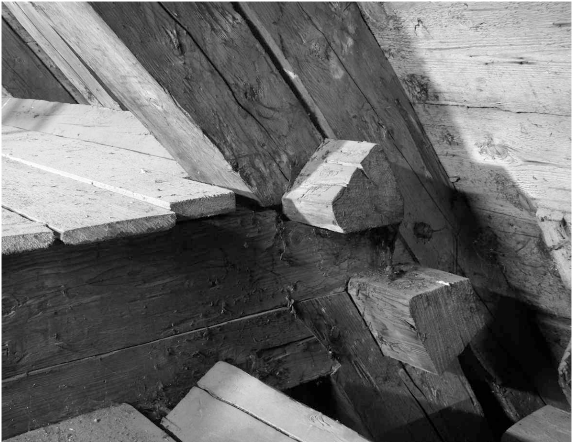
Abb. 2.13: Fünfeckige Fußschwelle (oben) und fünfeckiges Stuhlrähm (unten) zweier liegender Stühle aus dem Dachwerk der Pfarrkirche in Oberammergau
