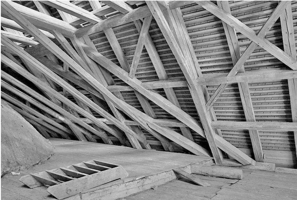
Abb. 2.42: Sprengwerk im offenen Dachwerksteil der Pfarrkirche Murnau
