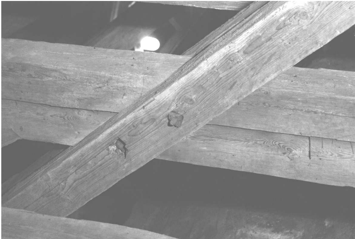
Abb. 2.29: Pfarrkirche Kirchweidach. Anschluss der als Zangen ausgebildeten Kreuzstreben an Spannriegel und Kehlbalken ohne Querschnittsschwächung ausschließlich mit zwei eisernen, gegenläufigen Gewindebolzen
