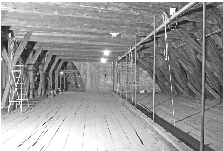
Abb. 2.30: Ev. Hl. Kreuz, Augsburg. links: Handgeschmiedete Eisenstangen, eingesetzt als Hängesäulen. rechts: Sechseckige Mutter am oberen Ende der handgeschmiedeten Eisenstangen
