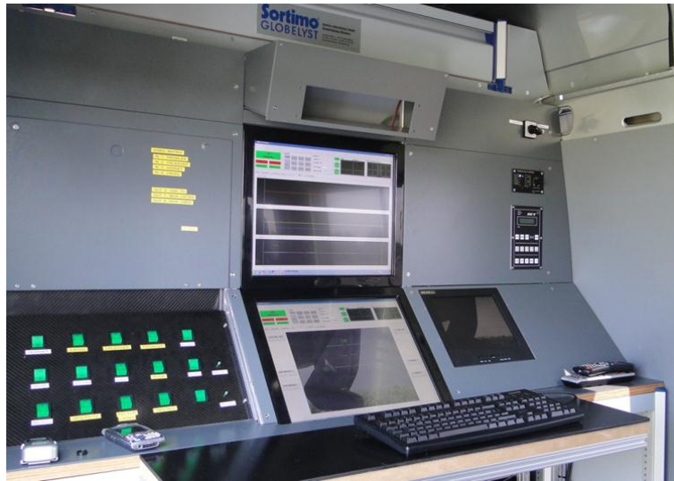
Abbildung 5-23. Arbeitsplatz des Operateurs innerhalb der Bodenkontrollstation
