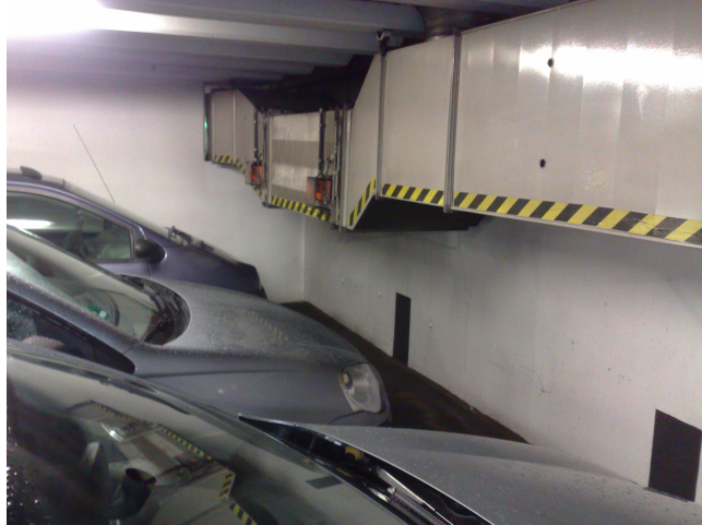
Abbildung 6.18 – Beispiel für eingeschränkte Parklücken in einem Parkhaus.
